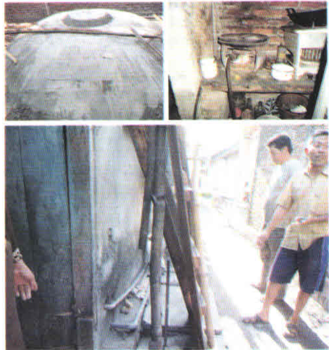
Gambar 5. Instalasi Biogas dari Limbah Cair Produksi Tahu dan Pemanfaatannya oleh Masyarakat
